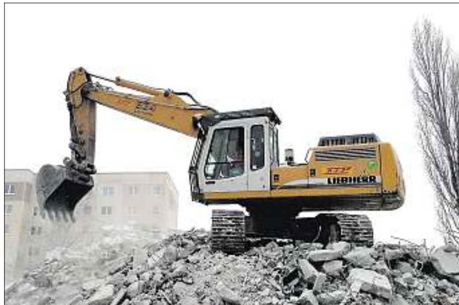
GEHT WEITER: In den Wohngebieten am Stadtrand wird wohl weiter abgerissen.
